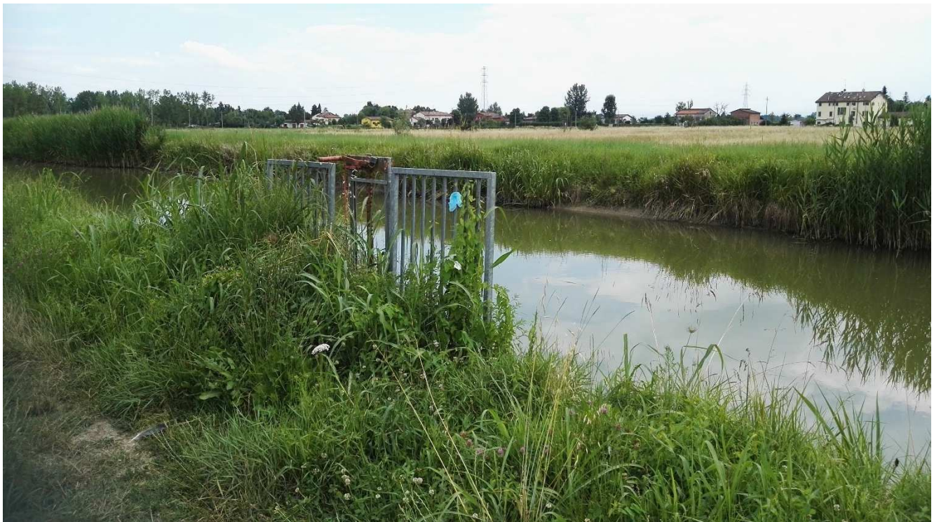
Figura 57 – Presa irrigua esistente lungo il Canale V in corrispondenza dell'inizio del canale Cavata Orientale
