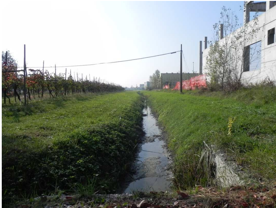
Figura 42 – Tratto 3 di intervento sulla CAVATA ORIENTALE (vista da valle, dal ponte di via Lama, verso monte; a sinistra della foto si nota il vigneto che non verrà interessato dalle operazioni di allargamento del canale e che costituisce un vincolo progettuale che limita la possibilità di creare una banchina allagabile)
