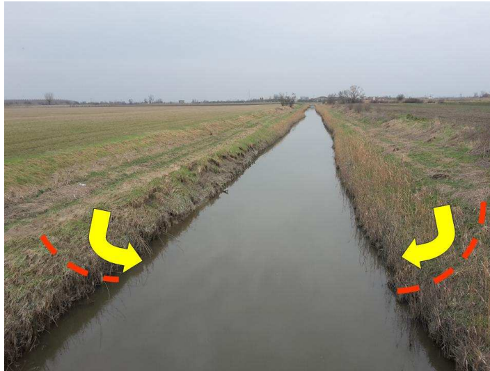
Figura 30 – Esempio della necessità di continuare a garantire la stabilità della sponda
