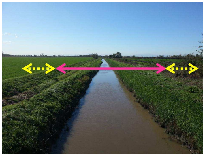
Figura 28 – Esempio di vincoli allo spazio a disposizione (in fucsia l'eventuale proprietà del Demanio alle Acque e in giallo l'eventuale proprietà pubblica aggiuntiva)
